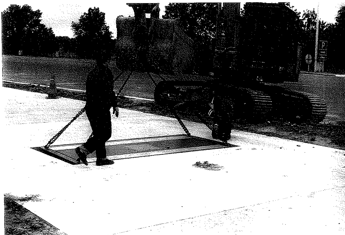
Fig.1 : Mise en place du pont bascule PRECIA.
