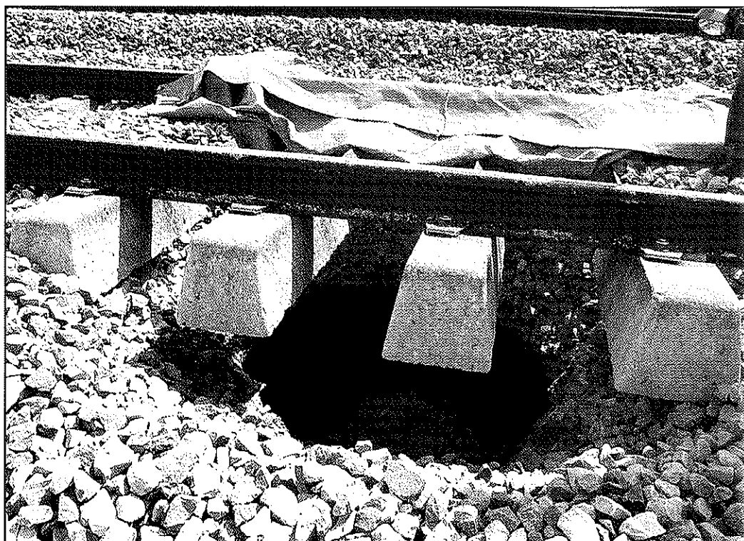
Un des impératifs de la SNCF sur la LGV Nord : détecter les fontis souvent à l'origine d'effondrements de terrain.
