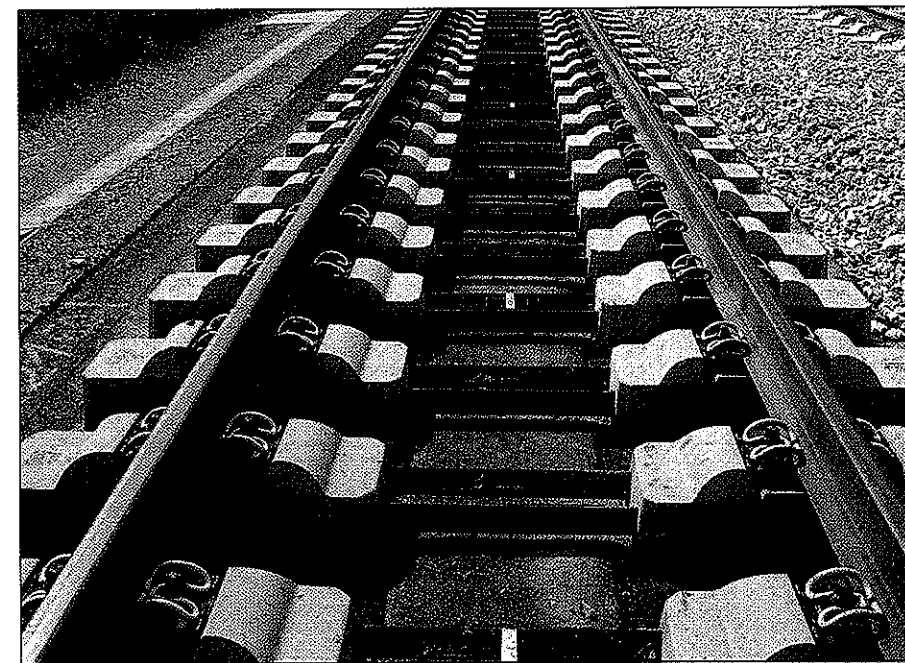
La voie sur dalle est déjà utilisée sur les lignes ICE.
