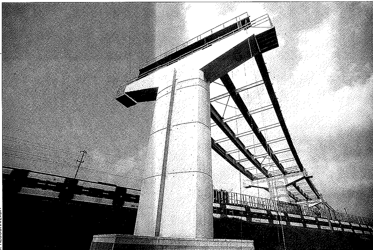
L'A 86 en chantier à Aubervilliers. C'est à cet endroit qu'elle enjambera la ligne B du RER.
