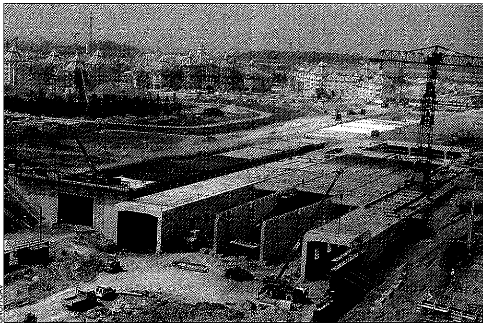
La gare de Marne-la-Vallée-Chessy, en construction. Au fond, Eurodisneyland.
