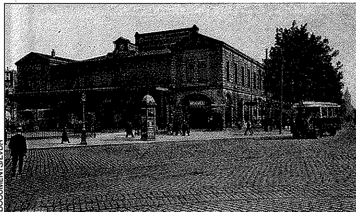
L'ancienne gare de la Bastille vers 1910, en lieu et place de l'Opéra du même nom.
