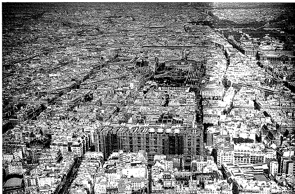
Paris : le quartier des Halles. Une densité de construction élevée et stable, mais une densité de population résidente décroissante.
