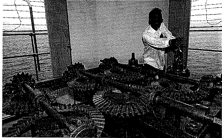
Au réservoir de Redhills, cet ingénieur contrôle le système qui propulse l'eau jusqu'aux stations de pompage du centre-ville. Ce réservoir de 93,5 millions de mètres cubes est rarement plein.
