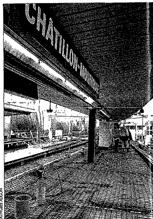
■ Sur la ligne 13, la pose de façades de quai a débuté. Ici, coulage de la dalle de béton à Châtillon-Montrouge.
