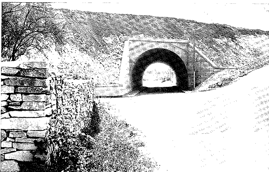
Voûte massif ancien chemin d'Anduze.
